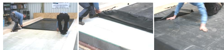
EPDM membraan verlijmen
