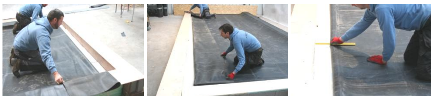
EPDM membraan terugplooiën
