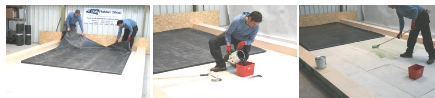
De EPDM folie tot in de helft terugvouwen, EPDM contactlijm aanbrengen
